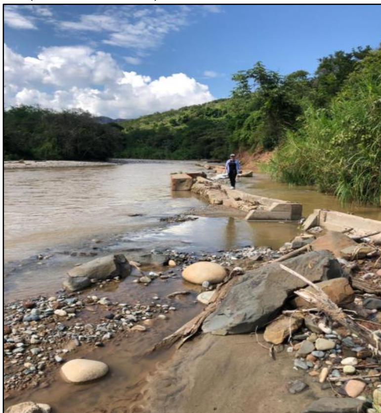
FIGURA 30. Erosión hídrica ocasionada por la canalización de riegos en el área.
