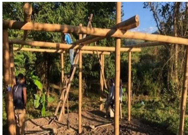
Anexo 13. 6 columnas de 2,40 m y 3 columnas centrales de 3,2m.
