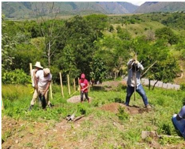
Anexo 55. Ahoyado mediante (ahoyadura, pica de hierro, barra)
