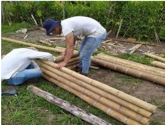
Anexo 30. Ensamble de módulos parte inferior
