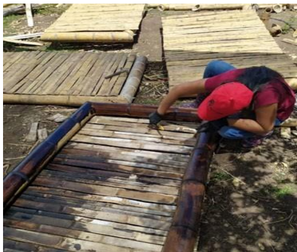
Anexo 23. Aplicación de alquitran a la base
