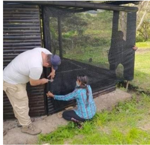
Anexo 19. Instalación malla polietileno.
