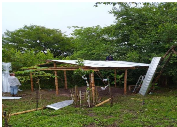
Anexo 15. Instalación hojas de zinc.
