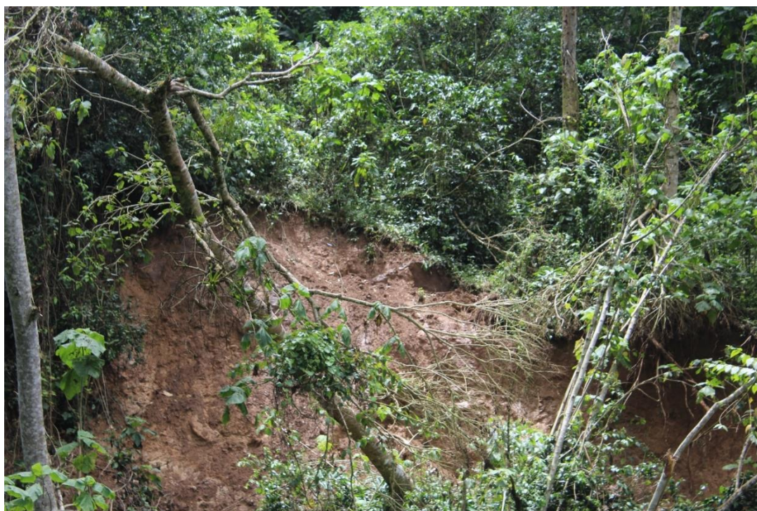
Figura 25. Deslizamiento de tierra en el área de estudio, Abril de 2017.
