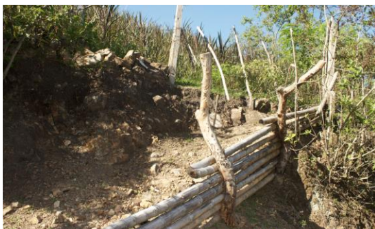
Foto 6. Control de suelos inestables
