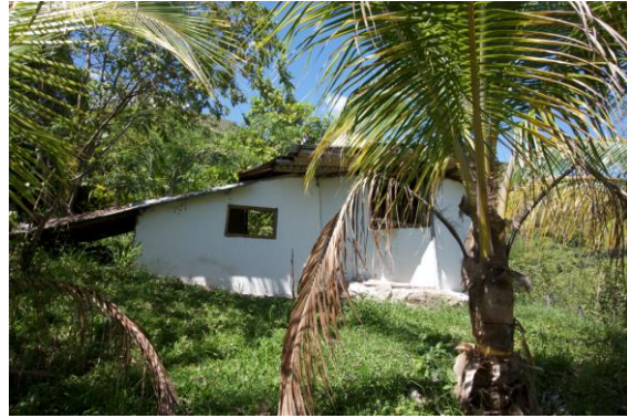
Foto 47. Cabaña en construcción
