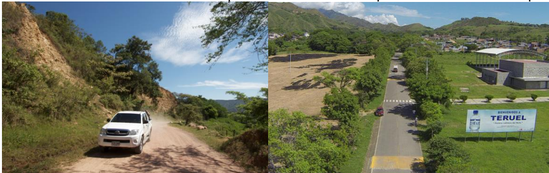
Foto 58. Tramo “Trocha” Teruel – Iquira Foto 59. Tramo pavimentado Teruel – Iquira
