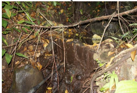
Foto 52. Bocatoma – Quebrada Frutas de Oro
