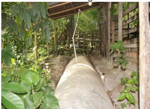
Foto 51. Planta de biogás
