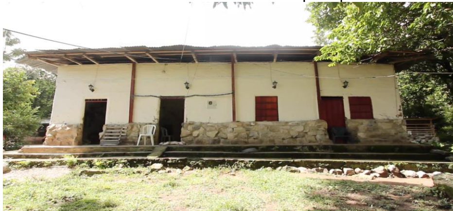
Foto 43. Casa de habitación principal
