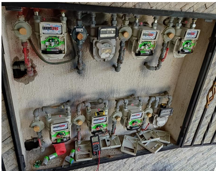
Figura 40: Instalación dispositivos GreenyWave del pilotaje de Alcanos
