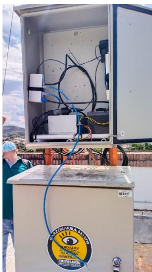
Figura 21: Punto de Conexión a internet del Gateway principal de Garzón
