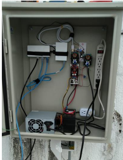
Figura 35: Punto eléctrico y de conexión a internet del Gateway en la cede de Alcanos
