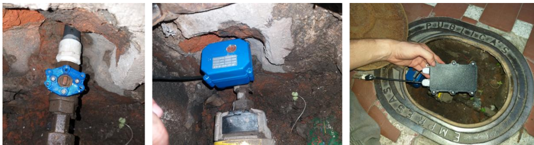
Figura 26: Instalación dispositivos de agua en pilotaje de Garzón
