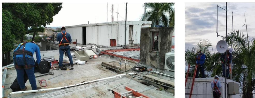
Figura 34: Instalación de la antena del Gateway en la sede de Alcanos
