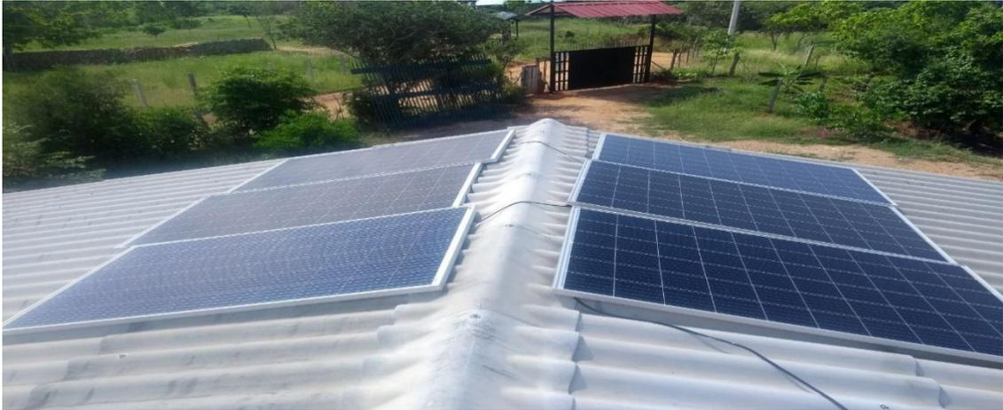
**FIGURA 16.** Paneles solares JA SOLAR 270 Watts instalados en el nodo Moscovia
