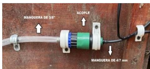
*Nota:* La Figura 67 indica el acople entre las dos mangueras requeridas, a la izquierda está la manguera que transporta el agua desde el tanque y a la derecha la que lleva el agua a las plantas. *Fuente:* Autores.
