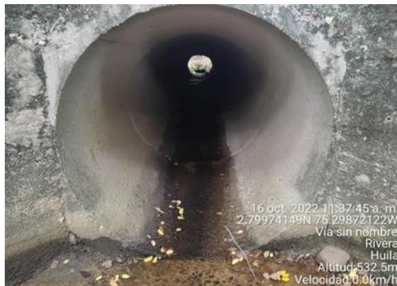
Figura 46: Alcantarillas de drenaje instaladas en el proyecto
