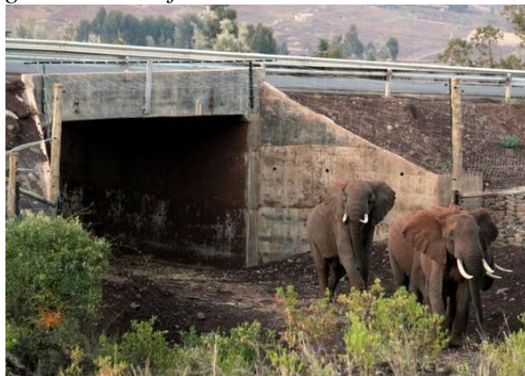
Figura 14: Paso inferior específico para grandes mamíferos
