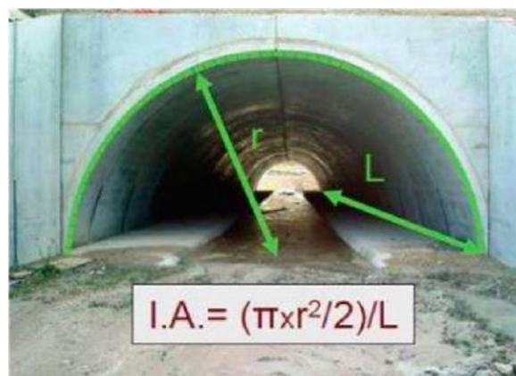
Figura 28: Formula de índice de apertura en redes de drenaje
