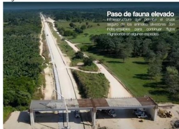
Figura 21: Construcción de pasos seguros para la fauna en México
