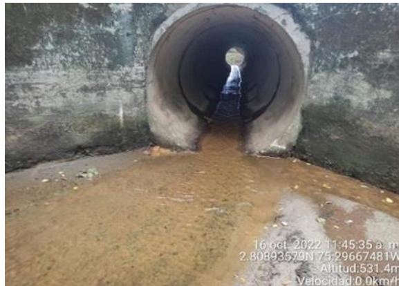
Figura 44: Alcantarillas de drenaje instaladas en el proyecto
