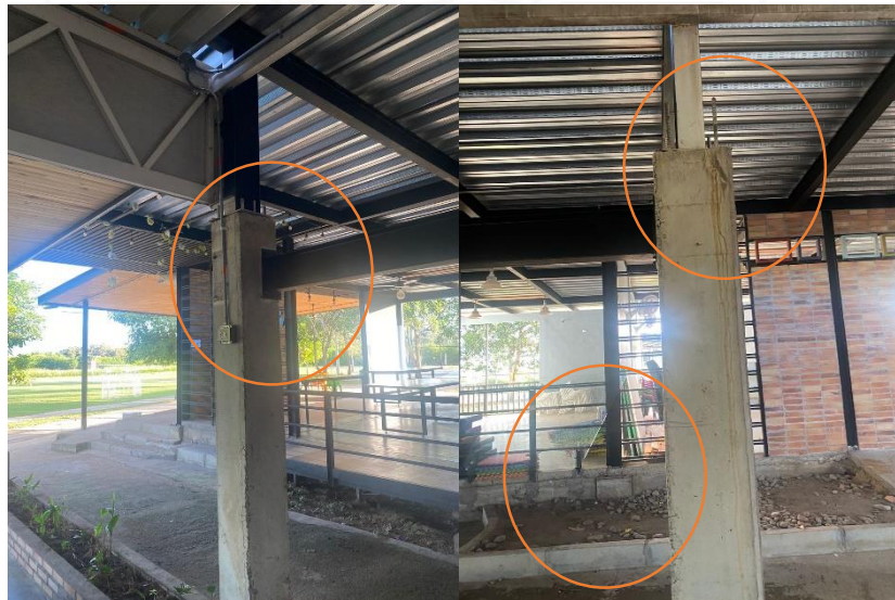
Figura 210 Infraestructura del restaurante sin terminar
