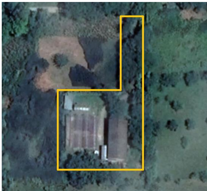
IMAGEN 1. Vista satelital de la planta de beneficio
