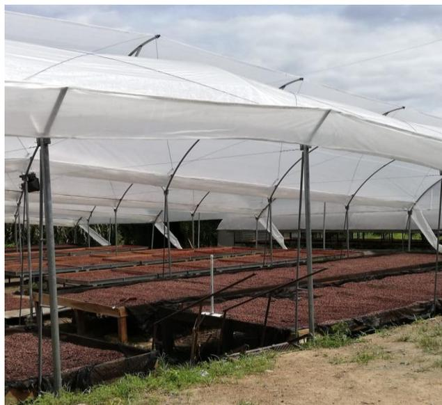
*Figura 2. Vista lateral secador solar tipo invernadero.*
