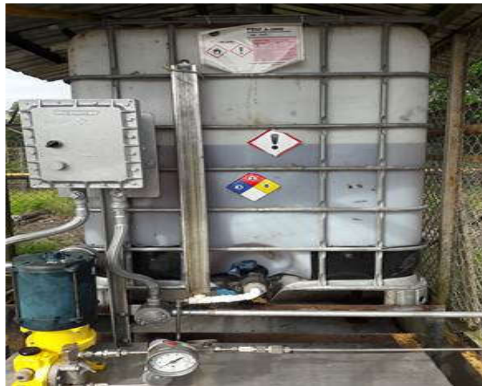
Figura 30. Esquema Facilidades en Superficie - Equipo en operación con bomba de química para inyección por el capilar hasta cabeza de pozo Madrugador-01.
