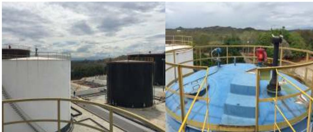
Figura 4. Tanque de techo cónico
