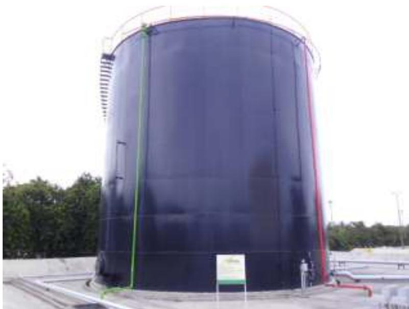
Figura 2. Tanque de techo fijo
