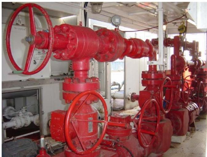
Ilustración 40: Ensamble de estrangulación tres vías, línea central 6” con líneas laterales de 4” & 5000/3600 psi (Fuente: Brochure “Ensamblajes de Estrangulación” Weatherford)
